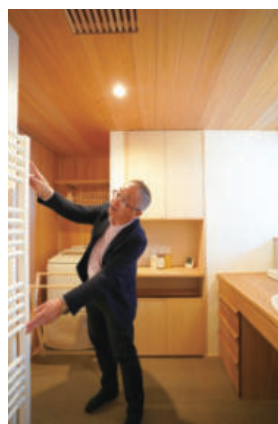
洗面脱衣室にはタオルの乾燥もできるパネルを設置。ヒートショック対策にも有効。
