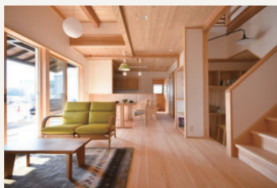
白太の部分を使用した明るい空間
