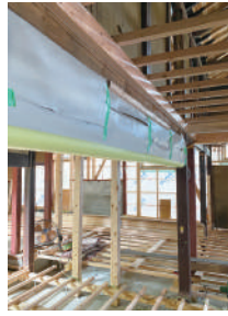
構造の不安な箇所を柱と梁で補強しました
