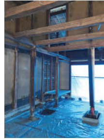
構造に負担のかかっている部分の補強工事。一旦ジャッキで家を受けて補強。
