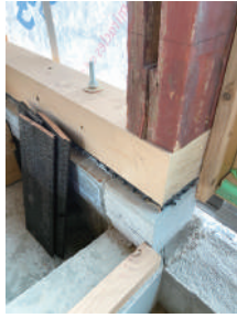
柱の足元が劣化している部分をカットして土台と基礎にて補強します
