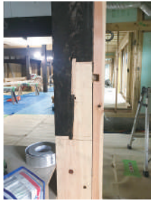
白アリの食害にあった柱の足元を根継ぎして直しています
