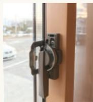
グラグラしている場合はネジを締めなおせばオッケイです。調整の場合は一緩めしてから調整するのですが、ネジは絶対に外さないでください！緩めすぎて両方のネジが外れてしまうと内側の留め具が落下してしまい取れなくなってしまうので、調整が終わればネジを締めてカバーを戻してください。
