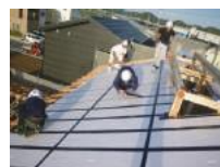
断熱・気密処理
