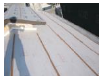
屋根防水完了
