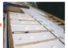
透湿シート張り
