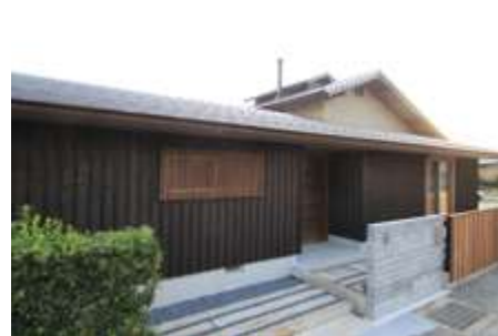
外壁は杉の板張り、しっとりとした和の佇まいの平屋
